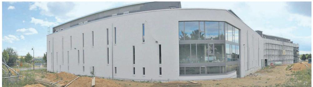
Die wärmedämmte Fassade zur Straße sorgt gleichsam für Schallschutz. Die Apartments selbst sind nach Süd-Westen ausgerichtet.
